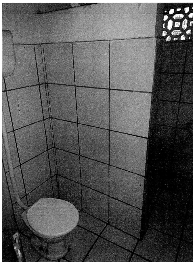
Imagem 28 – Banheiro da escola
