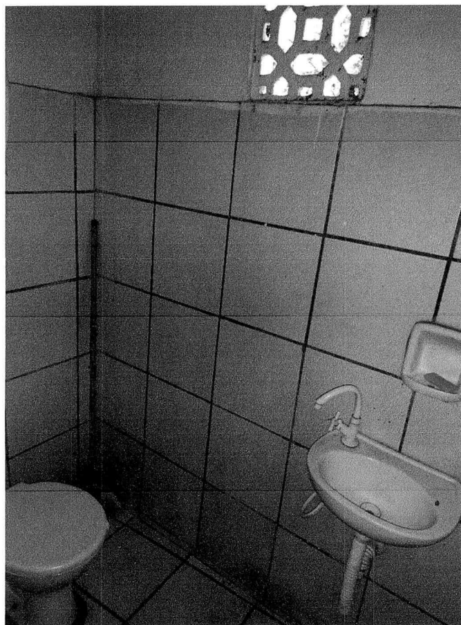
Imagem 29 – Banheiro da escola
